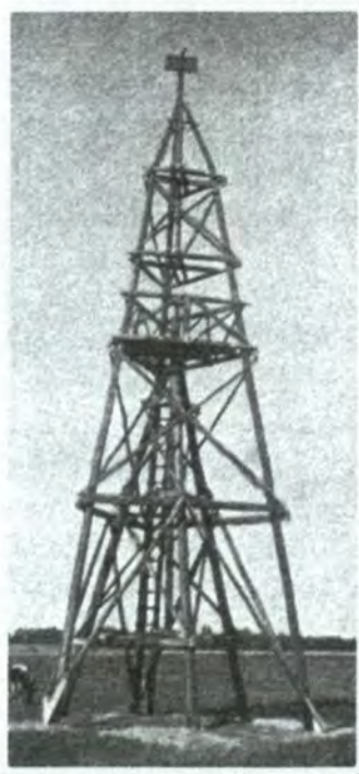
5 pav. III eilės trianguliacijos bokštai, kurių staliuko aukštis – 8,0 m, o signalinės dalies – 15,0 metrų.
