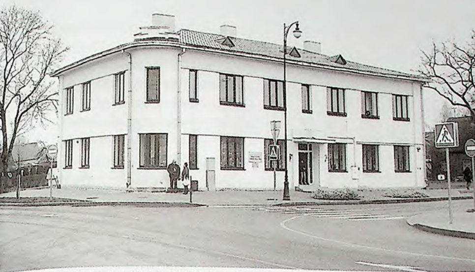
Juozo Keliuočio biblioteka Rokiškyje – tarpukario architektūros objektas
