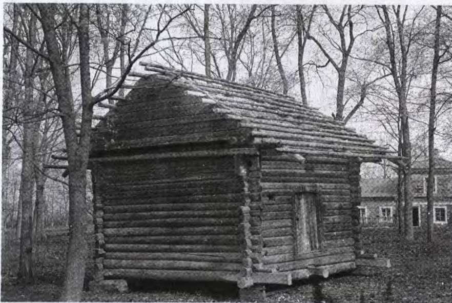
Jono Šinkūno klėties montavimo darbai. RKM-10202
